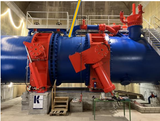
Drosselklappenkammer mit Tandem- Klappen
