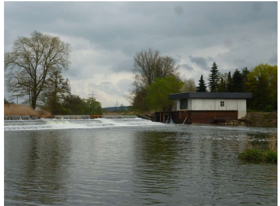
Abbildung 10: Außenansicht Wasserkraftwerk Altenkunstadt, Streichwehr und Turbinenhaus
