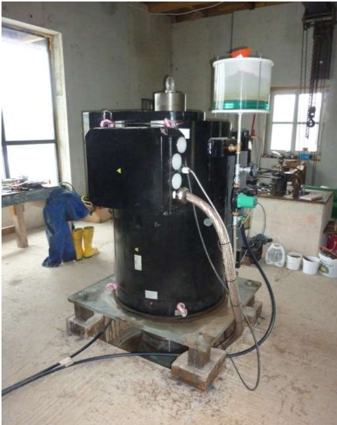
Abbildung 11: Permanenterregter Synchrongenerator
