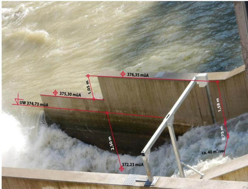
Sichtbare Eintiefung des Wasserspiegels ( $z_0 = 2,5$  m) unmittelbar nach der Rampe im Turbinenauslaufbereich
